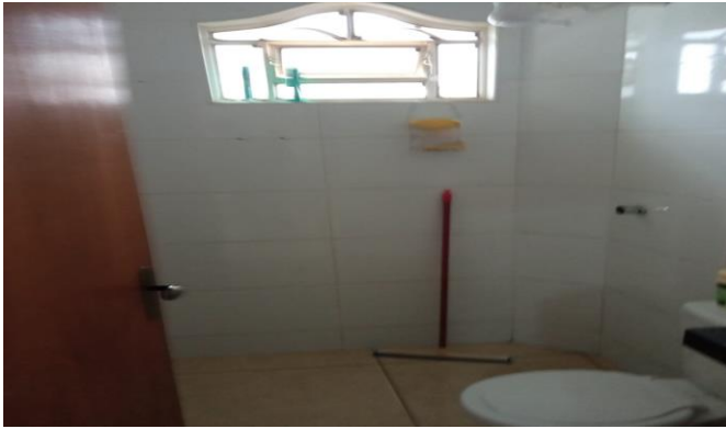
Banheiro Apto 1º Andar A
